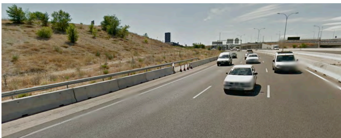
Ilustración 11: Fotografía donde puede verse parte del carril de aceleración vallado por estar inhabilitado al tráfico.
