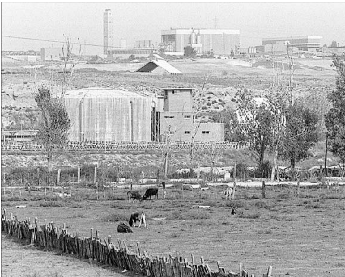
Alrededores de la depuradora Sur. / GORKA LEJARCEGI
