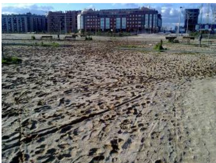
Parcela 4.6 y 5.2. Estado en que queda el parque tras la lluvia. No existe ningún tipo de acera que atraviese este inmenso parque.
